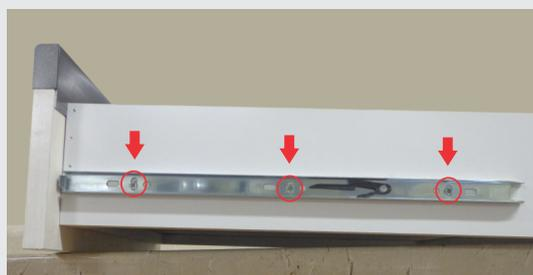
Retire a Gaveta e afrouxe os parafusos da corrediça do lado que se encontra desalinhado, regulando até a altura necessária. Em seguida aperte novamente os parafusos.
